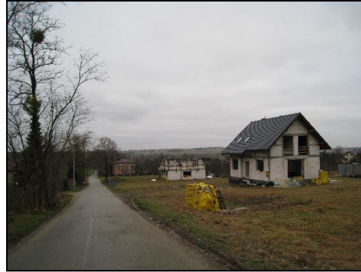
Fot. 7 Zabudowa tuż poza północno-zachodnią granicą obszaru
