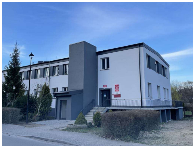
Nowa siedziba Ośrodka Pomocy Społecznej w Siewierzu.
