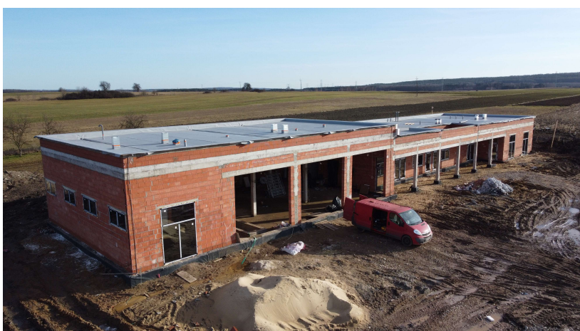
Budowa Remizy OSP Gołuchowice
