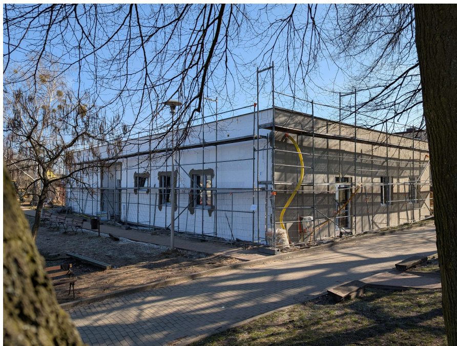
Budowa Żłobka Gminnego w Wojkowicach Kościelnych
