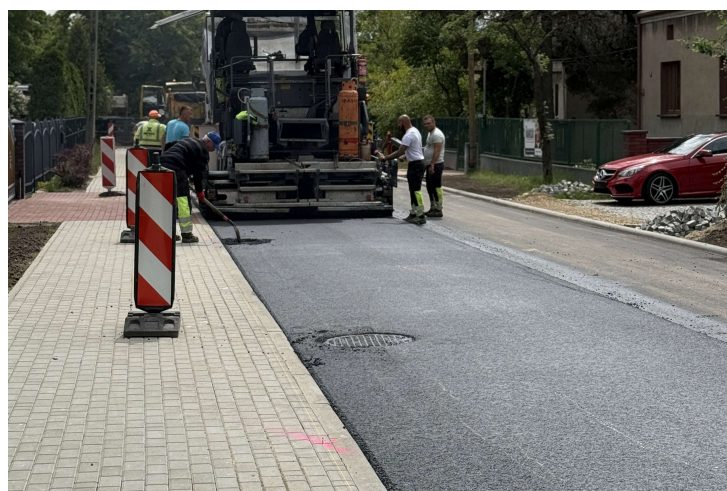
Remont ul. Żeromskiego w Siewierzu
