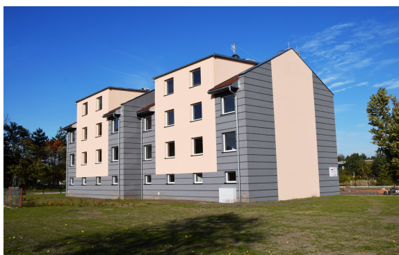
Budynek przy ul. Bema 8 w Siewierzu.
