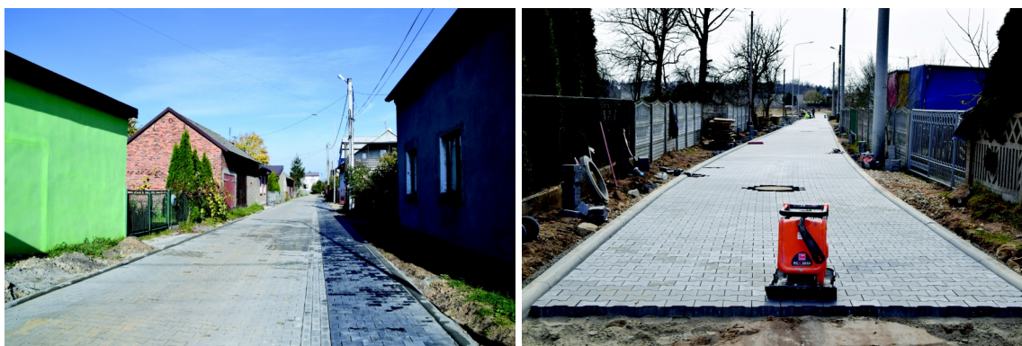
Budowa kanalizacji sanitarnej i deszczowej w części miasta Siewierz - tzw. Piwoni.
