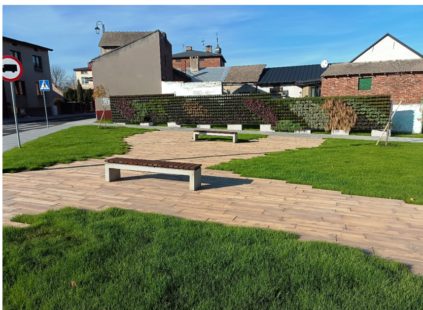
Ulica Krakowska po przebudowie.
