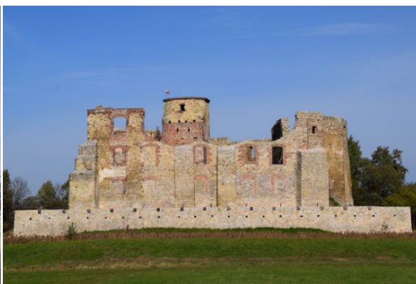
Widok zamku po zakończonych pracach.
