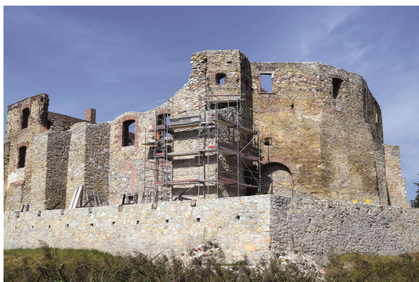
Prace konserwatorskie i budowlane na zamku.
