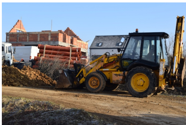
Prace przy przebudowie drogi gminnej w Tuliszowie.
