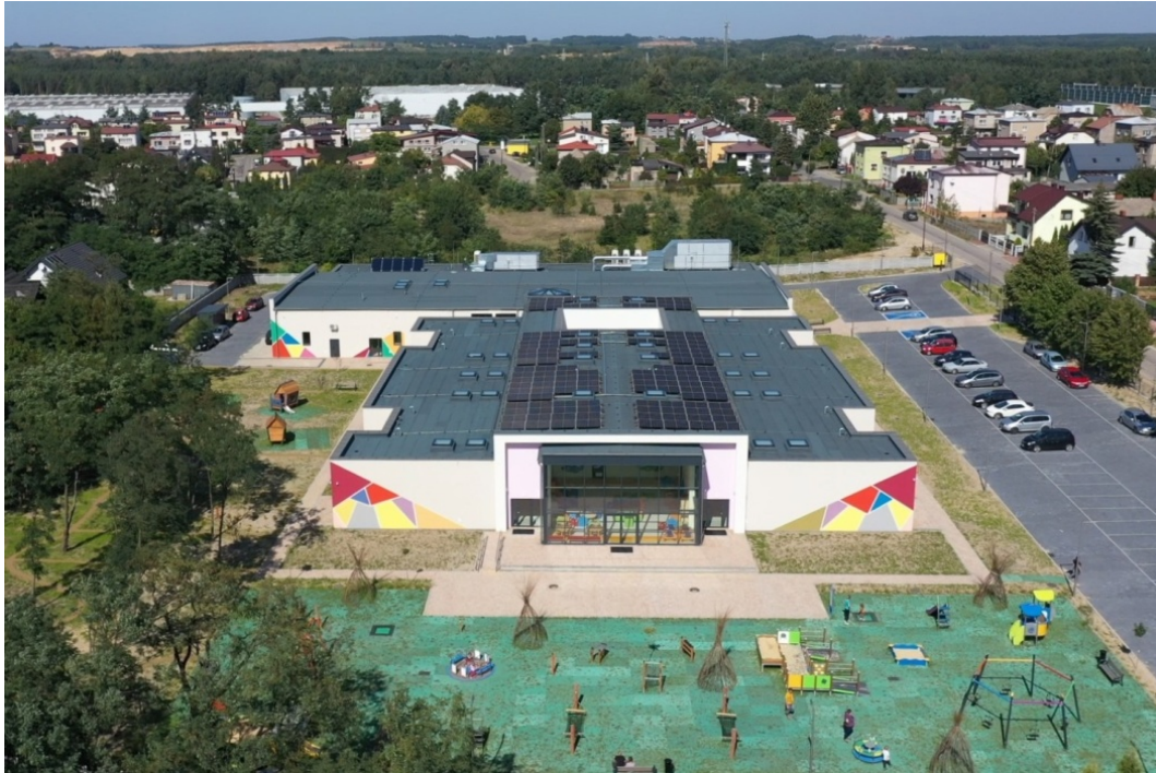
Budynek przedszkola i żłobka z zamontowaną instalacją fotowoltaiczną
