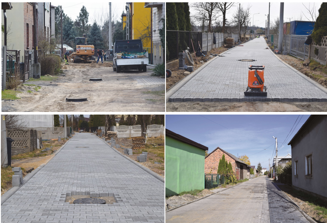
Budowa kanalizacji sanitarnej i deszczowej w części miasta Siewierz - tzw. Piwoni.
