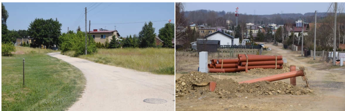
Budowa drogi gminnej na ul. Chabrowej w Siewierzu.
