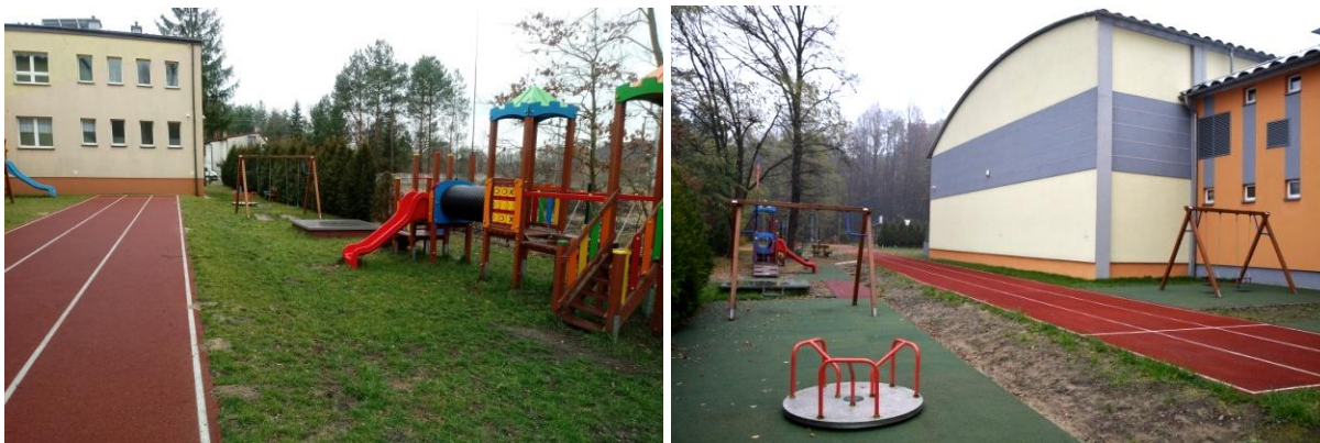
Teren placu zabaw przy szkole podstawowej nr 2 w Siewierzu przed i po zagospodarowaniu.
