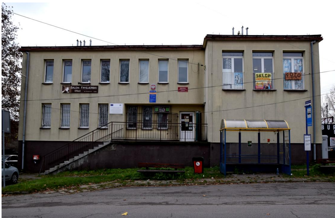
Budynek komunalny w Wojkowicach Kościelnych przed remontem.
