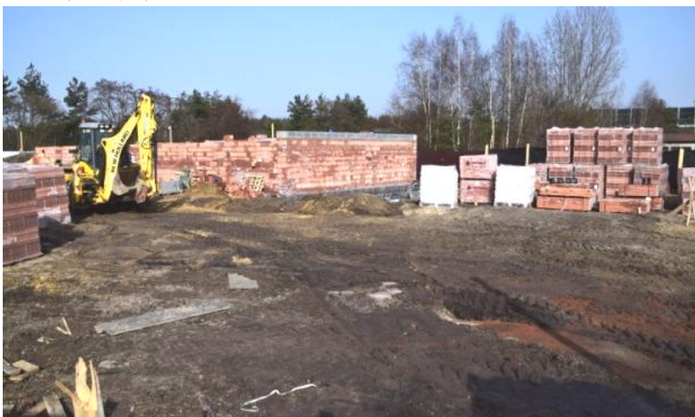
Rozpoczęcie prac przy budowie budynku wielofunkcyjnego przy ul. Gen. J. Bema w Siewierzu.
