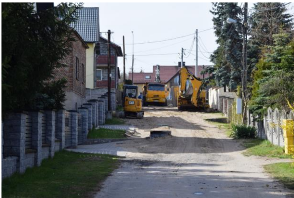
Prace przy budowie kanalizacji w Piwoni.
