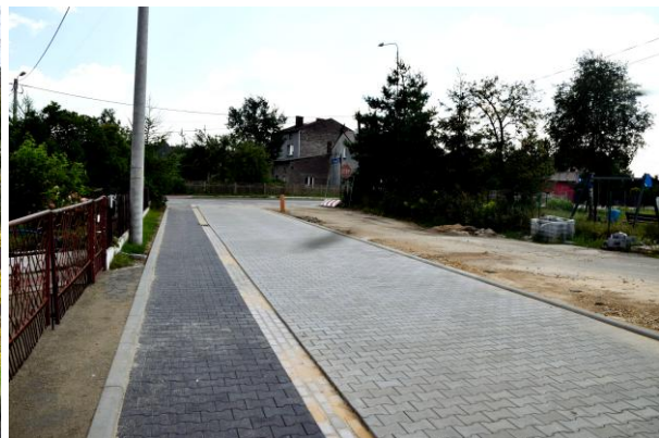
Fragment ul. Leśnej po zakończeniu prac.
