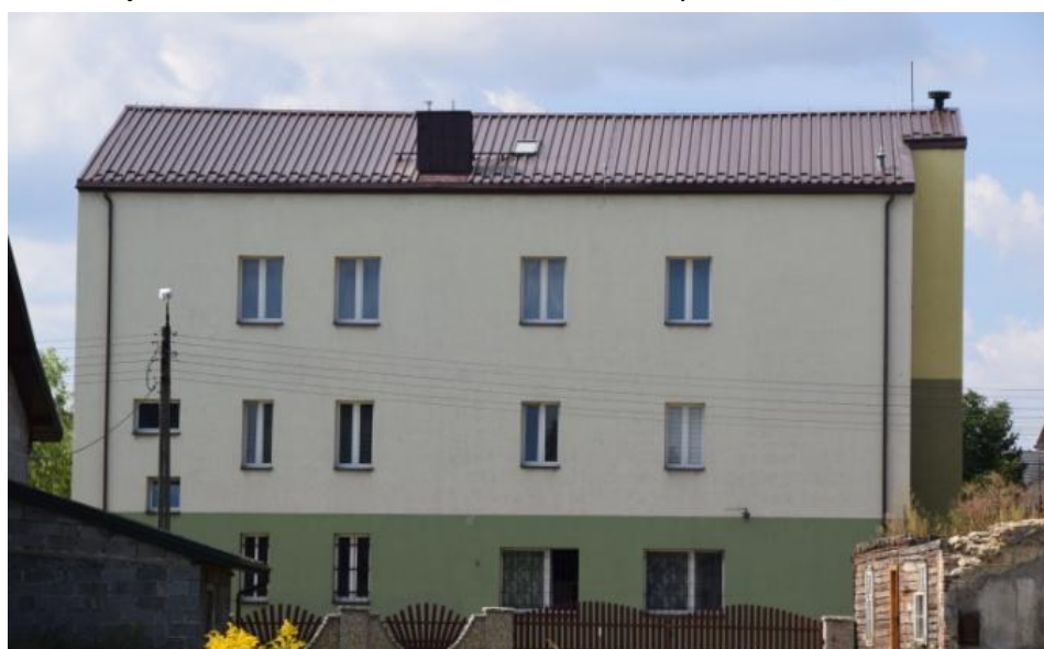
Remiza OSP w Żeliszawicach z nowym pokryciem dachowym.
