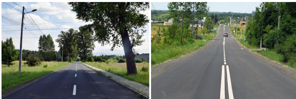
Przebudowana droga powiatowa nr 4706 S.
