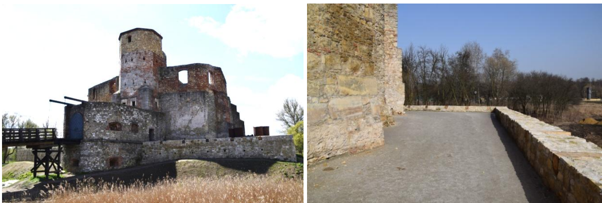
Widok zamku po zakończonych pracach.
