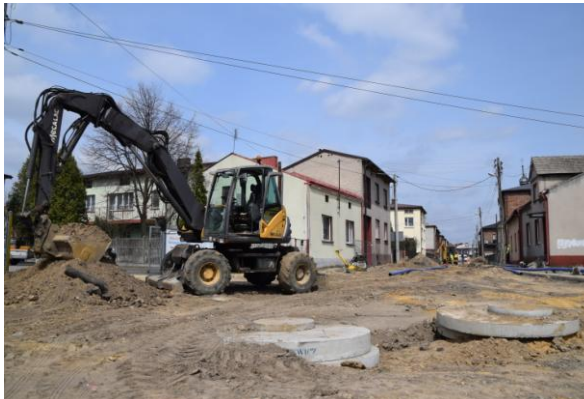
ul. Krakowska w trakcie przebudowy.
