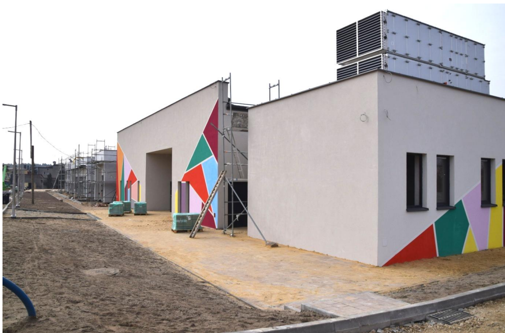
Prace przy budowie przedszkola z oddziałami integracyjnymi.
