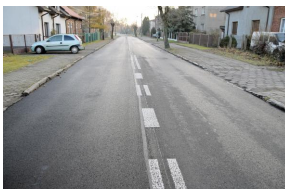
Ulica 11 Listopada po przebudowie.
