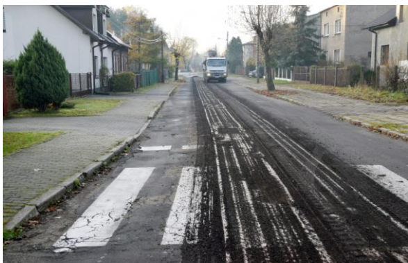
Prace przy budowie drogi na ul. 11 Listopada.
