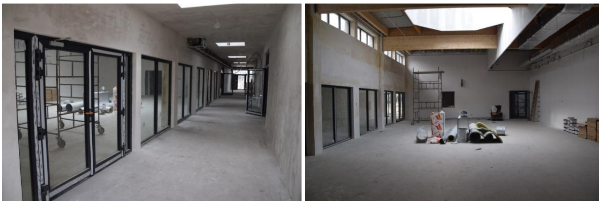
Prace wykończeniowe w budynku przedszkola i żłobka.
