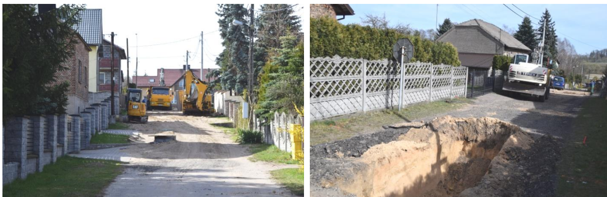
Budowa kanalizacji sanitarnej i deszczowej w Piwoni.
