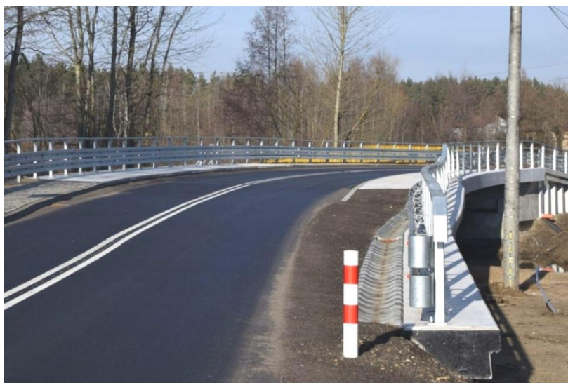
Przebudowany most nad rzeką Mitręgą w ciągu ul. Zagłębiowskiej w Siewierzu.
