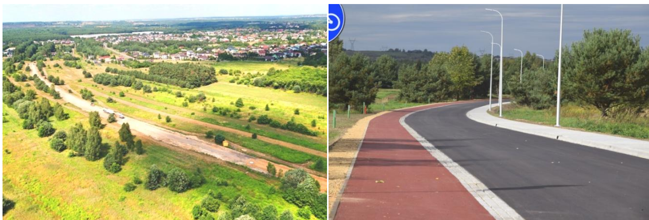
Droga gminna łącząca Osiedle Zachód i Osiedle Jezioro z ul. Bytomską w Siewierzu – przed budową i obecnie.
