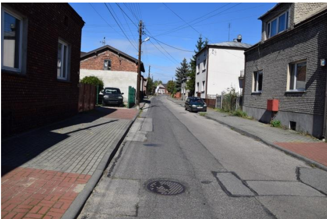
Droga na ul. Wolności w Siewierzu przed remontem.
