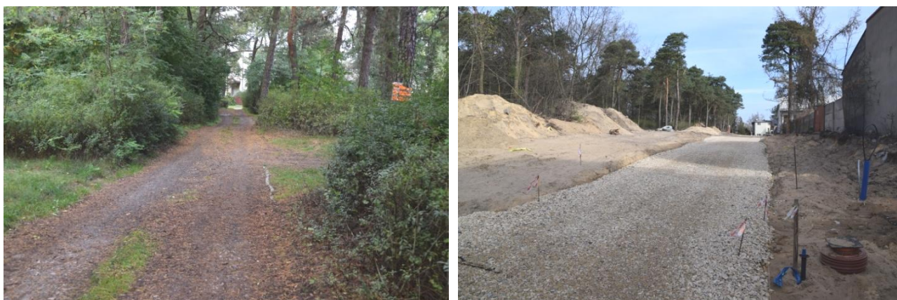
Odcinek drogi gminnej dojazdowej łączącej ul. Parkową z ul. Polną w Siewierzu – przed budową oraz w trakcie prac.
