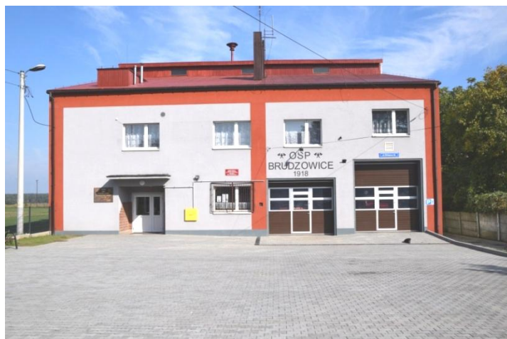
Budynek remizy OSP w Brudzewicach po remoncie.
