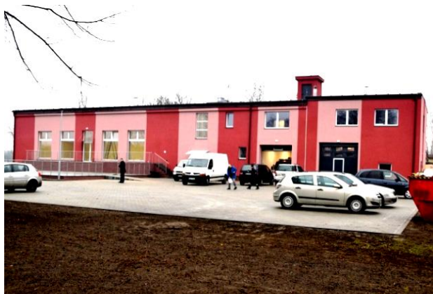
Budynek remizy OSP w Wojkowicach Kościelnych po remoncie.
