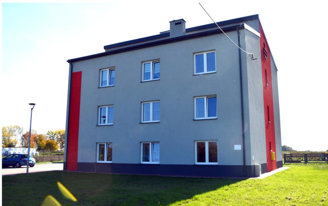
Budynek socjalny na ulicy Górnej w Siewierzu.
