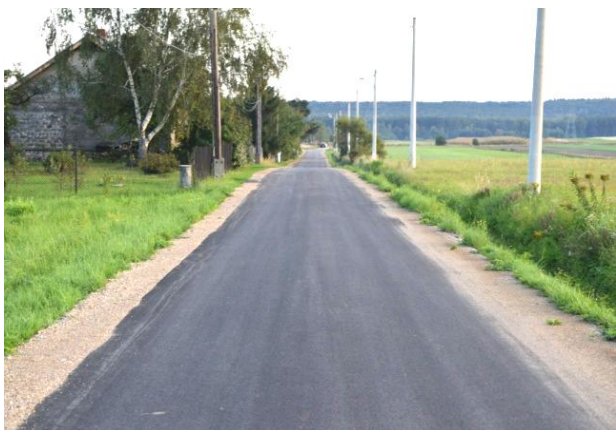
Nakładka asfaltowa na ul. Komorniki w Gołuchowicach.
