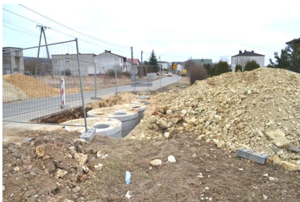
Prace przy remoncie drogi w Podwarpiu.
