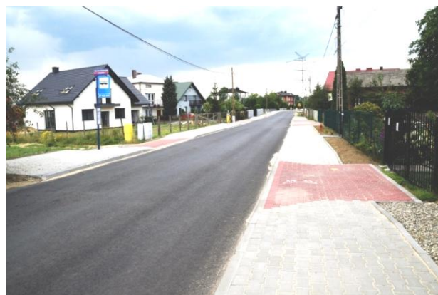
Droga w Podwarpiu po remoncie.
