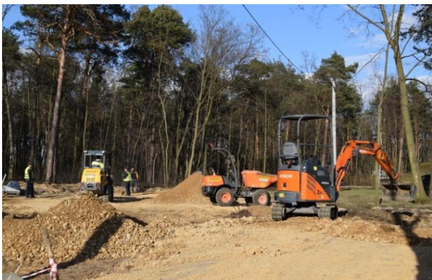
Prace przy budowie parku miejskiego w Siewierzu.
