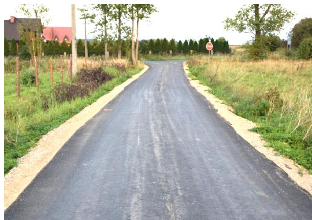
Modernizacja drogi na ul. Wiśniowej w Siewierzu
