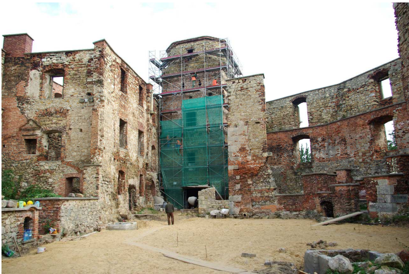
2.4. Zamek książąt śląskich, w latach 1443-1790 biskupów krakowskich – książąt siewierskich (Nr w rej. A/777/67). - w trakcie prac rekonstrukcyjnych murów i brukowania dziedzińca (11.09.2008 r.)
