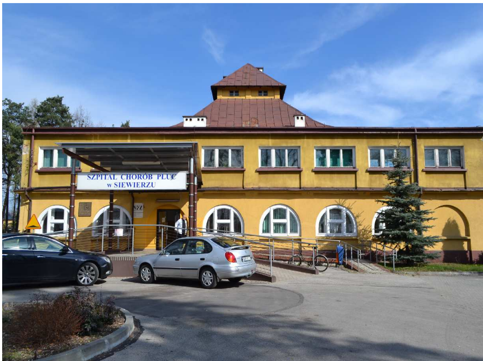
3.22 budynków Szpitala Gruźliczego w Siewierzu przy ul. Oleśnickiego 21. Budynek główny.
