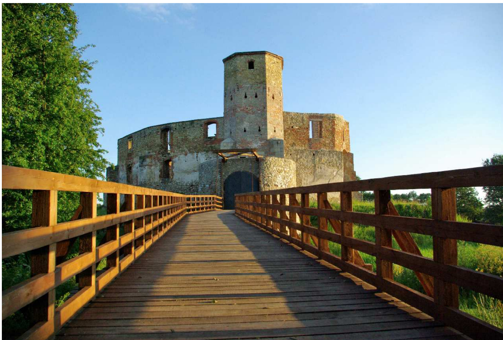
2.4. Zamek książąt śląskich, w latach 1443-1790 biskupów krakowskich – książąt siewierskich (Nr w rej. A/777/67) Po remoncie. Widoczne: kładka dla pieszych i most zwodzony.
